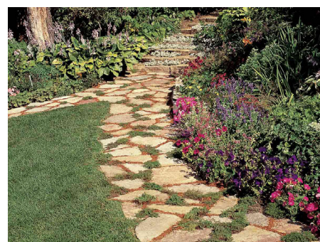
Pad met zand of aarde ertussen (breek bv. je stoeptegels in stukken)
