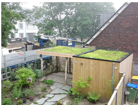
Groen dak, bijvoorbeeld met sedum
